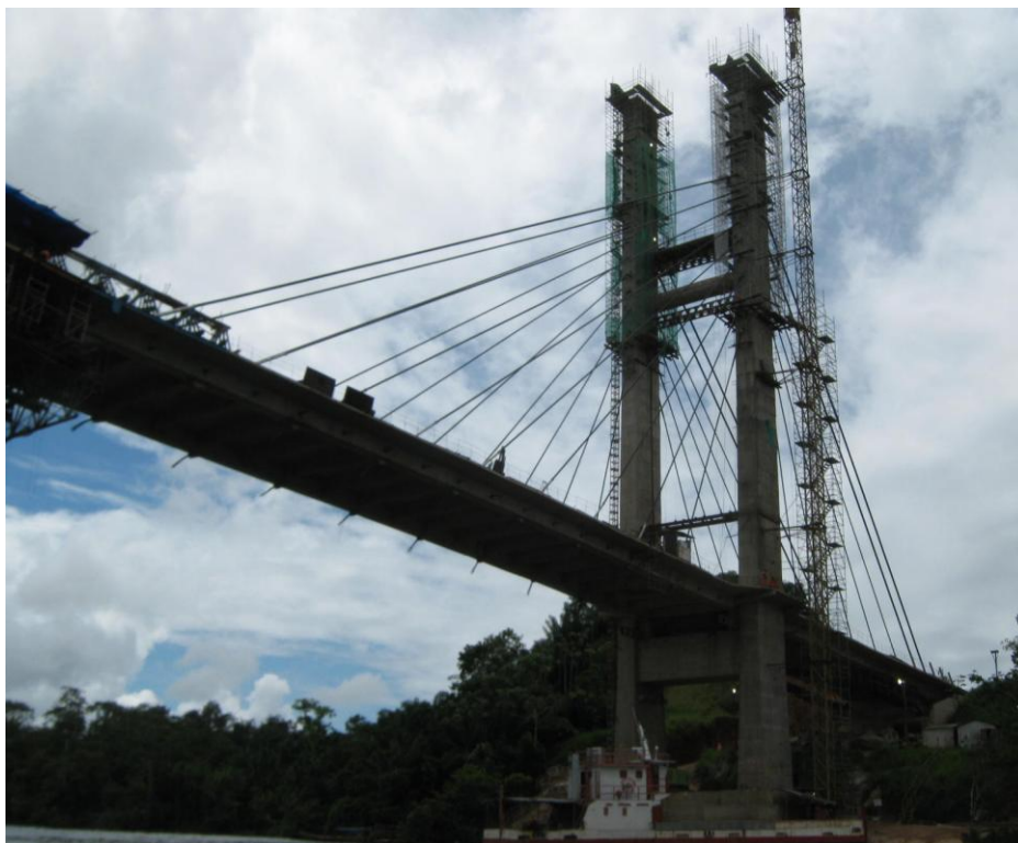
Fotografia 25: PONTE BINACIONAL SOBRE O RIO OIAPOQUE – Estágio avançado em que se encontra a construção da ponte binacional sobre o rio Oiapoque, na sede do município do Oiapoque (AP), interligando o território brasileiro à Saint-Georges, na Guiana Francesa.
