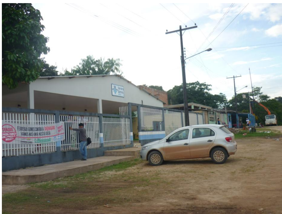
Fotografia 14: SEDE DA USINA HIDRELÉTRICA COARACY NUNES - escritório administrativo situado na sede do município de Ferreira Gomes. Autoria: Ana Regina Silva, 24/03/2011
