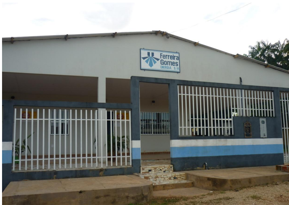
Fotografia 24: SEDE DA EMPRESA FERREIRA GOMES ENERGIA S.A. - localizada no centro urbano da cidade de Ferreira Gomes (AP). Autoria: Ana Regina da Silva, 24/03/2011
