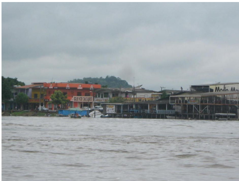
Fotografia 17: CIDADE DE LARANJAL DO JARI - vista de chegada à cidade através de voadeira (barco motorizado) na travessia sobre o rio Jarí, partindo do Distrito de Monte-Dourado (PA). À direita, estrutura edificada em dois pavimentos usada para a guarda de centenas de bicicletas, cujos usuários atravessam o rio diariamente rumo à Monte Dourado, onde trabalham nas empresas de mineração.
